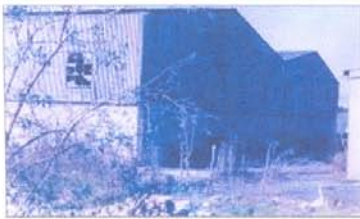
Εργοστάσιο Παπαρήγα - κτίριο αποθήκης έτοιμου προϊόντος
